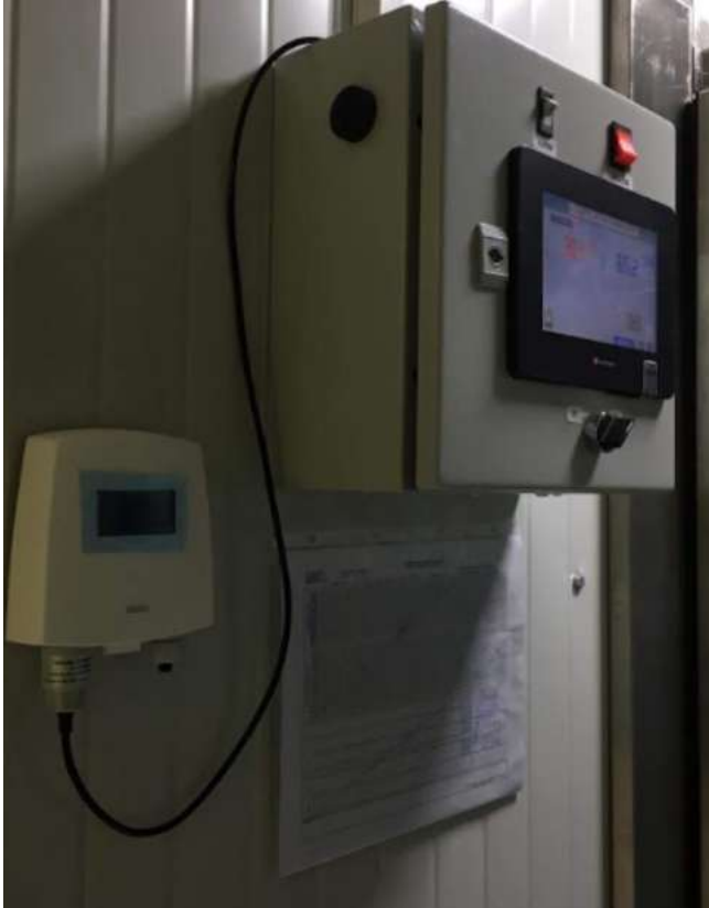
Fig. 3. Sistema para medir humedad y temperatura
