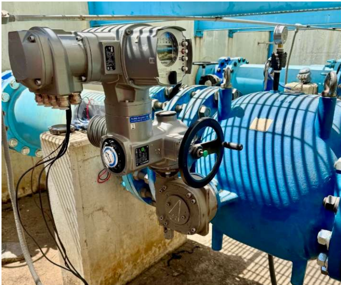
Fig. 3. Actuador Eléctrico AUMA en una Válvula de Bola
